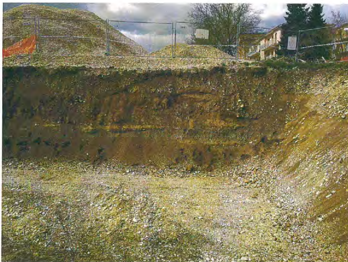
Figura 26 - Sbancamento nei depositi alluvionali sabbioso-limosi con lenti ghiaiose in sinistra del F. Gizio, a sud-ovest del centro abitato di Sulmona.
