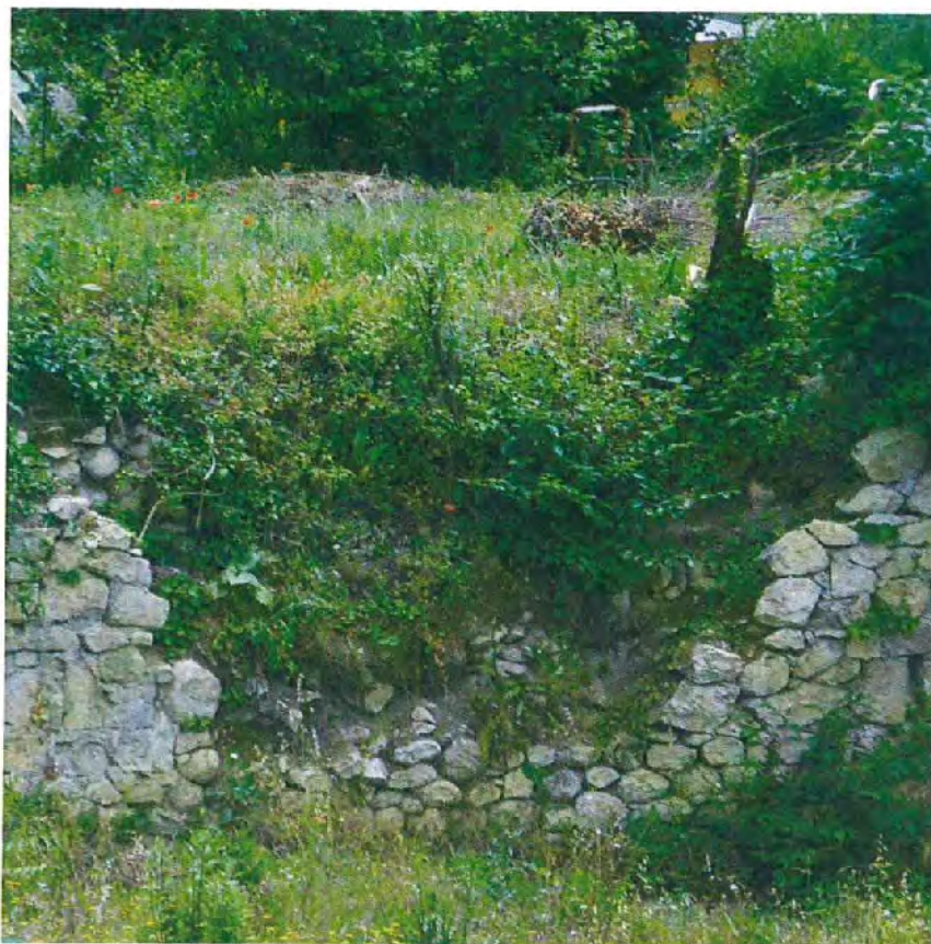
Figura 29 – Versante occidentale su cui è ubicato l'abitato di Sulmona: cedimento di un muretto a secco che mette alla luce un deposito antropico con spessore di circa 2 metri.
